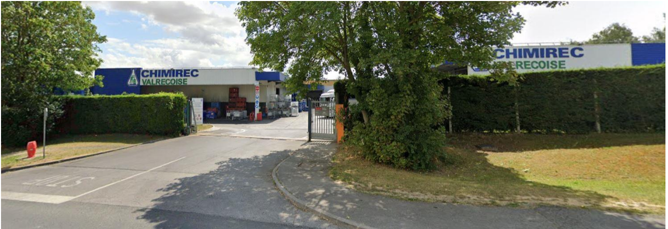
Vue depuis l'accès au site CHIMIREC VALRECOISE (ICPE) depuis la route industrielle (Les bâtiments A et B sont en partie visibles, les haies permettent de réduire les vues) (6)
