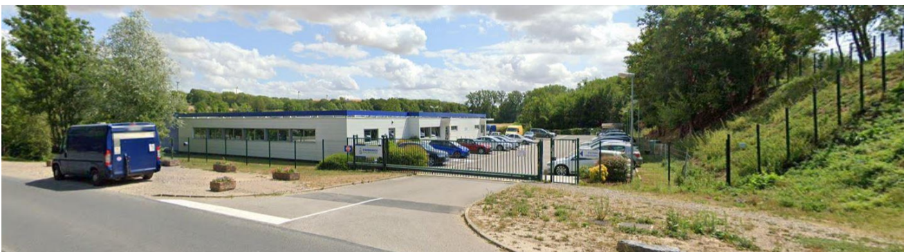
Vue en direction du bâtiment administratif de l'établissement CHIMIREC VALRECOISE depuis la route industrielle (Le bâtiment, de faible envergure, est directement visible ainsi que les véhicules légers stationnés. Le talus séparant la partie ICPE existante et la partie administrative est également visible (côté droit)) (6)
